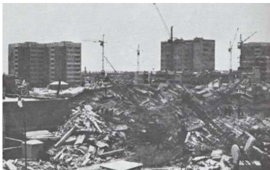
Fig. 6: Colapso de edificios prefabricados por los efectos de un terremoto. 1988, Spitak (Armenia).
