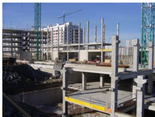
Fig. 9: Construcción de edificio plurifamiliar con elementos prefabricado de hormigón. Barrio de Zabalanga, Vitoria.
