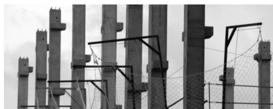
Fig. 10: Proceso constructivo de viviendas en altura. Barrio de Zabalanga, Vitoria.
