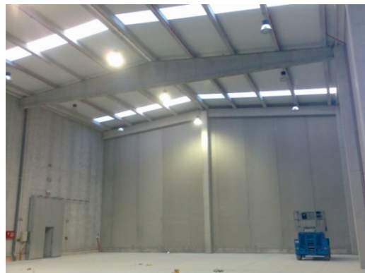
Fig. 5: Edificio industrial, Polígono Ind. Santiga-Provasa, Barberà del Vallès (Barcelona). Estructura y cerramientos de hormigón prefabricado.
