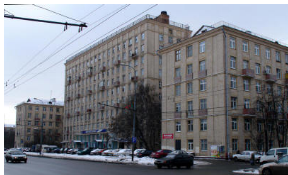
Fig. 2: Edificio Lagutenko-Posokhin, Moscow. Construcción industrializada basada en diseños cerrados.
