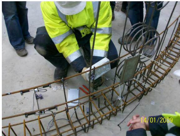
*Figura 9. Muntatge de la caixa de connexió dels instruments, que s'utilitzarà posteriorment per les lectures.*
