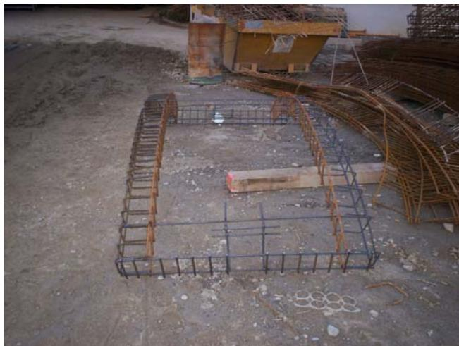
*Figura 7. Armadura convencional optimitzada pel cas de l'anell amb fibres.*
