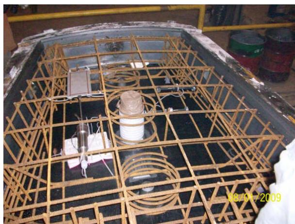
*Figura 6. Col·locació de la dovella instrumentada al motlló de formigonat. (convencional)*
