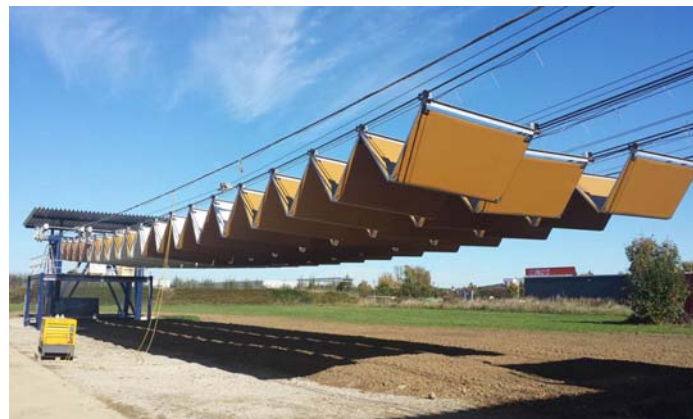
Fig.09 Los lienzos de 2,80 x 1,40 m están enmarcados con perfiles tubulares.
