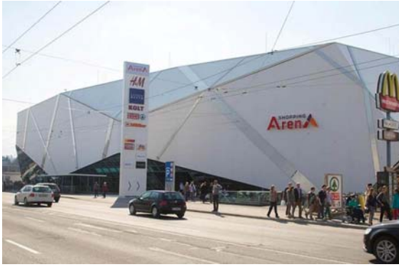
Fig.10 Renovación de la envolvente exterior del centro comercial SCA, Salzburgo realizada por Temme/Obermeier.
