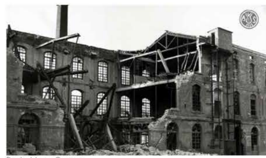
Derribo del vapor Casanovas
