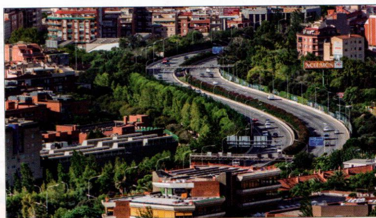
Foto 2. Vista diurna del tramo de la autopista B-23 en el que se realizó la experimentación.
