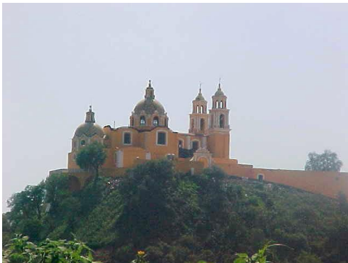
Foto No.5 Santuario de los Remedios. Proceso concluido agosto 2002.
