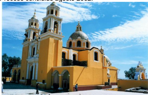
Foto No.6 Santuario de los Remedios. Proceso concluido agosto 2002.
