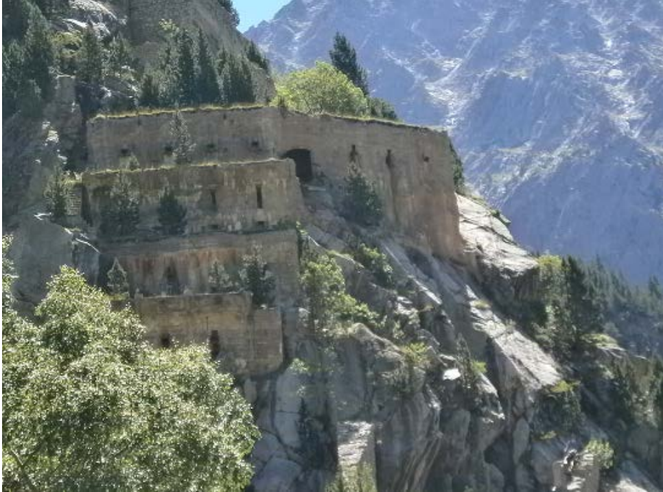
Fotografia 5. Obres de reforç, prop de la gravera de la Pressa de Cavallers. Vall de Boí
