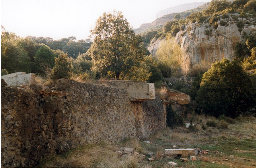
Fotografia 5. Restes dels rentadors (“lavaderos”) de les mines de lignit
