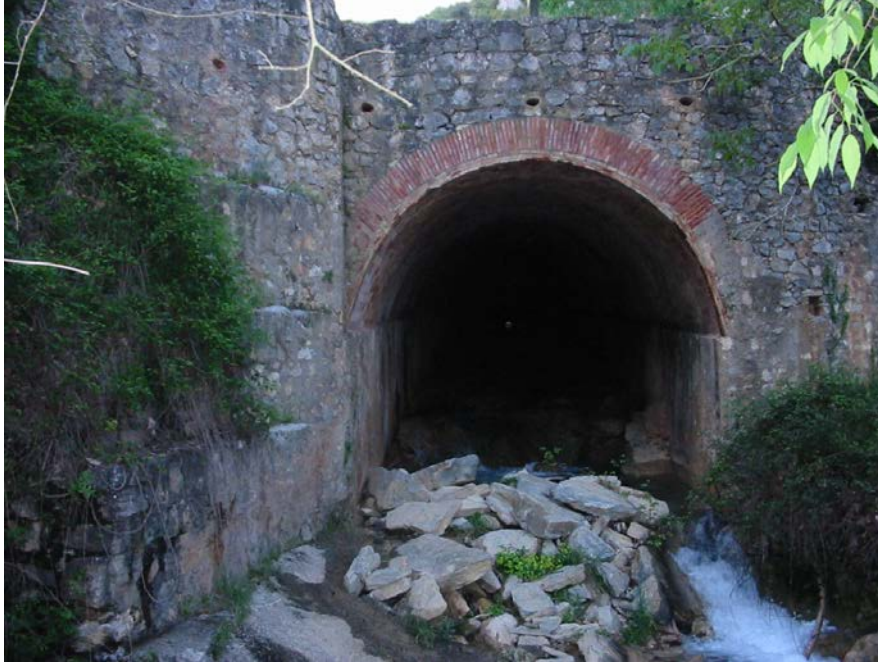
Fotografia 7. Túnel del riu Boix
