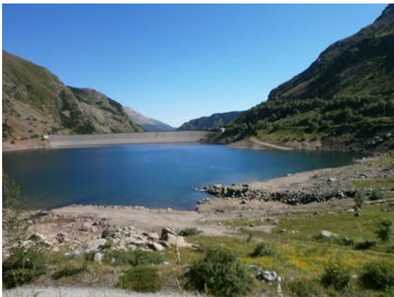
Fotografia 11. Un aspecte de l'embassament de Sallente Juliol 2013
