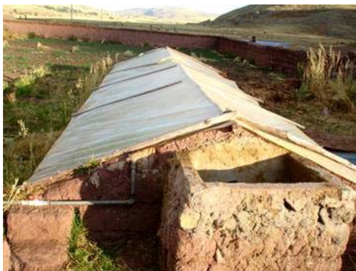
Figura 4. Digestor cubierto por invernadero a dos aguas
