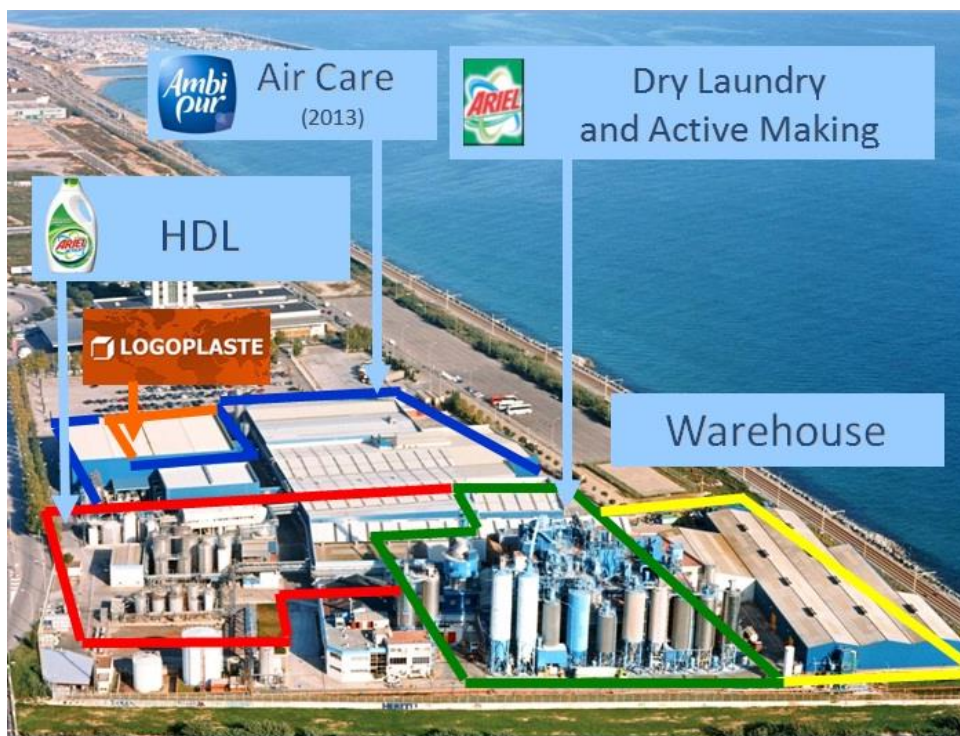
Figura 1. Planta de Mataró. Sectorización. En azul: ubicación “Ambipur”.
