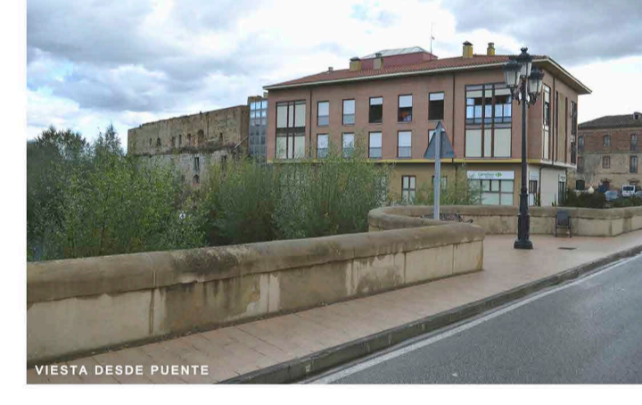
VISTA DESDE PUENTE
