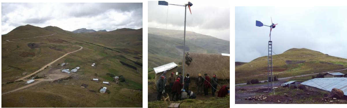
Figura 1. Vista general de la comunitat i dels aerogeneradors instal·lats.
