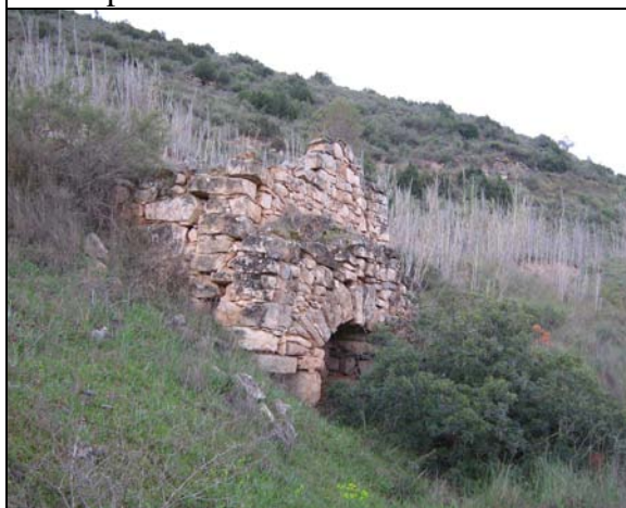
Restos del horno
