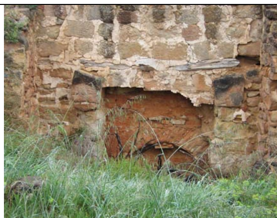
Aspecto de la boca de uno de los hornos
