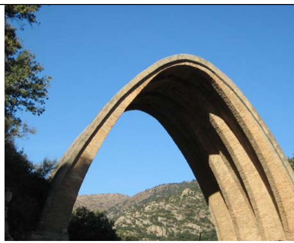
Otro aspecto del puente de protección (Sestrica)
