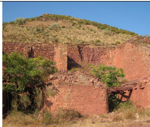
Tolvas de la estación inicial (Tierga)
