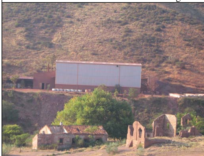
Restos de las viejas instalaciones
