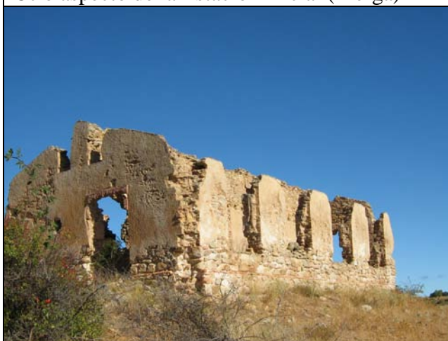
Restos de la estación de ángulo (Sestrica)
