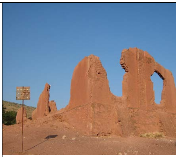
Estado actual de las instalaciones
