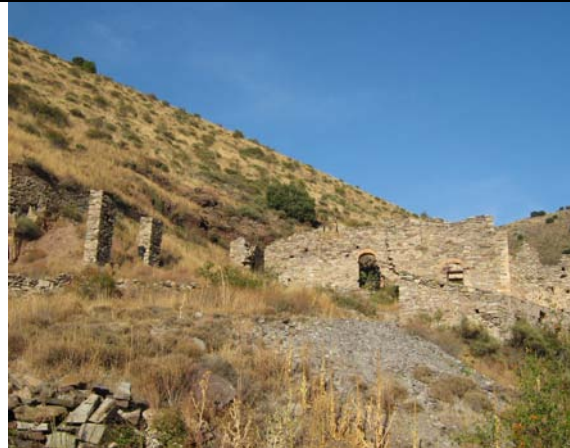
Zona meridional de las instalaciones
