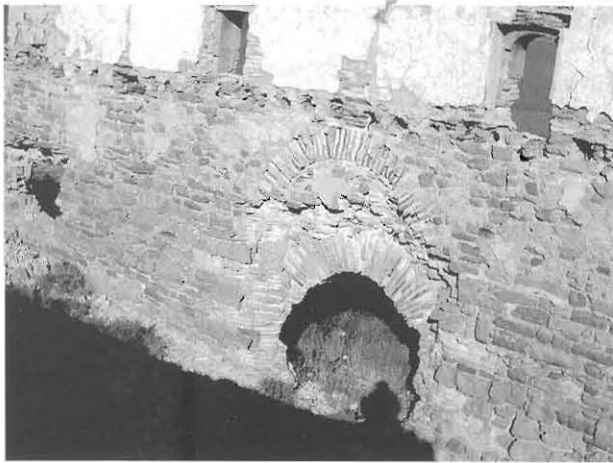
El edificio de acopio de la sal
