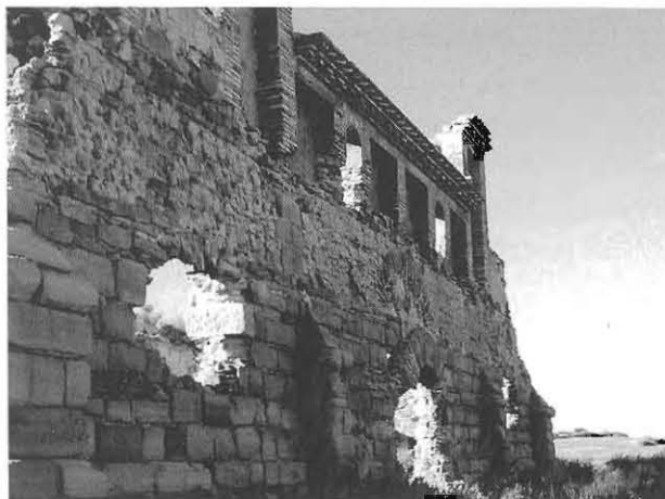
Aspecto frontal del edificio
