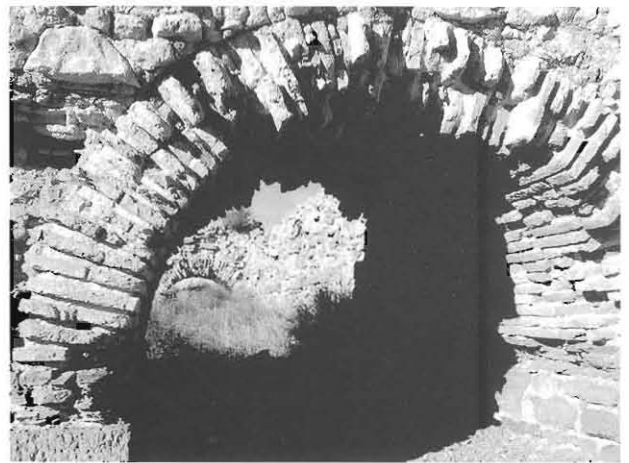
Otro aspecto del edificio de acopio
