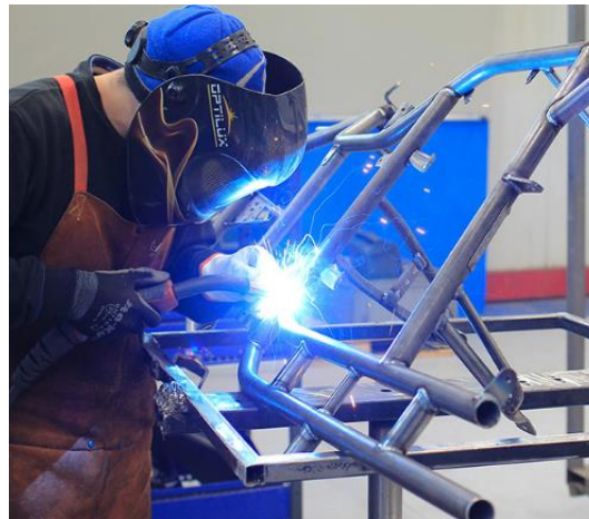
Figura 61: Soldadura bastidor
