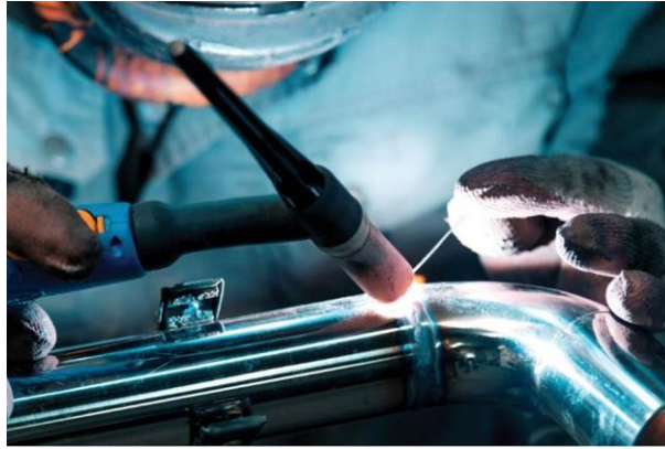
Figura 65: Operario soldando con TIG
