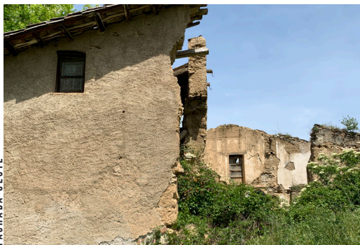
IMG.1 FACHADA OESTE
