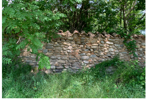
IMG.23 MURO DE CONTENCION 2M
