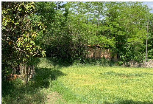
IMG.3 MURO FACHADA SUR
