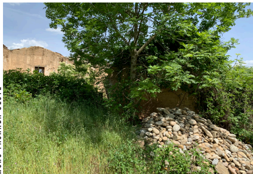
IMG.4 MURO FACHADA OESTE
