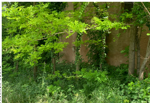
IMG.2 FACHADA NORTE
