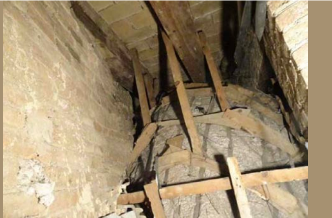
Figura 5. Interior cielo raso, subestructura madera que genera geometría y capa superior malla con cemento natural
