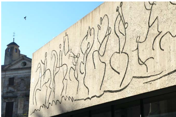
Figura 3: Friso de la Senyera . Fotografía realizada durante los trabajos del estudio diagnóstico.
