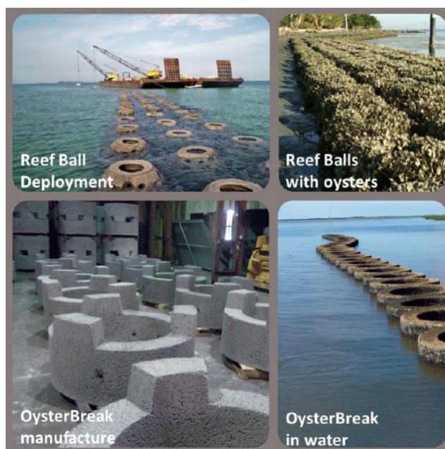
Figura 13. Disseny d'escull de formigó prefabricats. Font: Stokes et al., 2012
