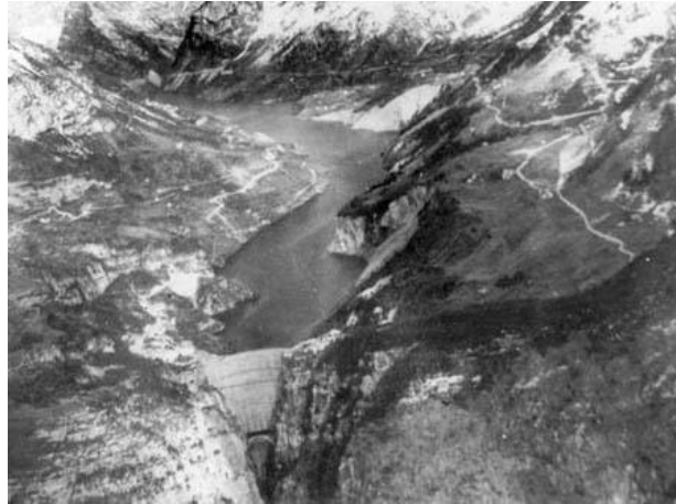
Figura 1.2.3 Derrumbe en Vajont. Fuente: yesano.com
