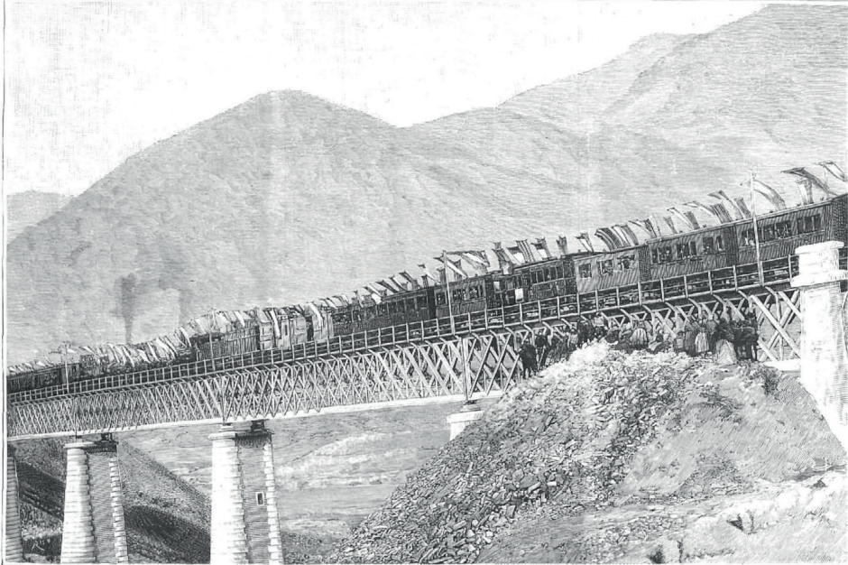
BARCA DEL ALBA (SALAMANCA).—INAUGURACIÓN DEL PUENTE INTERNACIONAL SOBRE EL ÁGUEDA, EN EL CAMINO DE HIERRO DE SALAMANCA Á OPORTO, EL 8 DEL ACTUAL.—(De fotografía remitida por D. Santos Tordesillas.)
