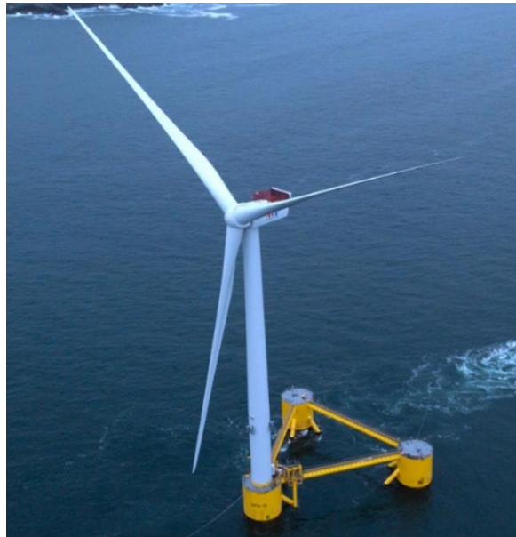
Figura 94. Plataforma eòlica flotant tipus Semi-submergible (WindFloat Atlantic) [43]
