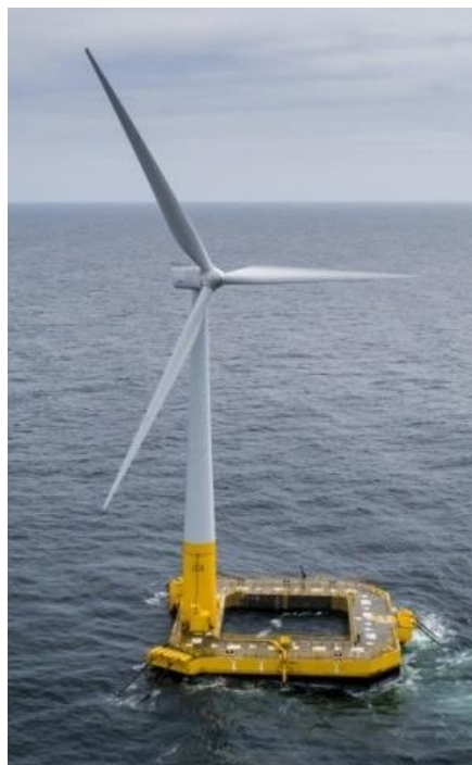
Figura 93. Plataforma eòlica flotant tipus barcaça (Floatgen) [44]
