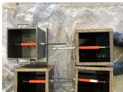
*Ilustración 37.- Moldes con barras instaladas para hormigonado.
