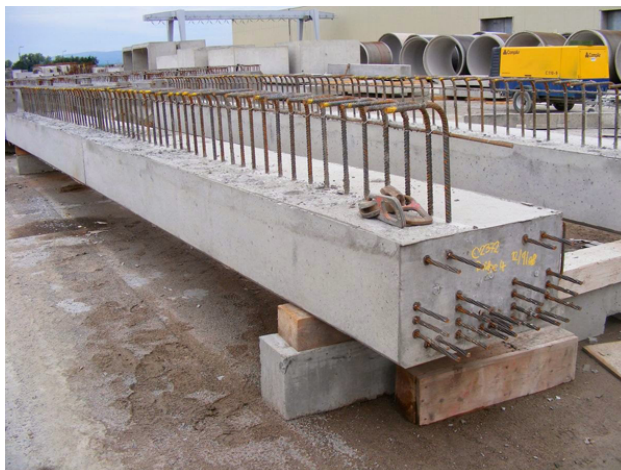
Figura 2.6: Preparació del formigó pretensat
