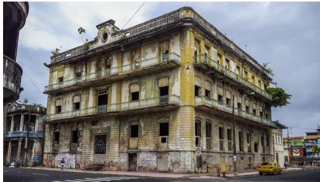
Figura 2.3: Edifici on es pot veure una millora dels elements estructurals
