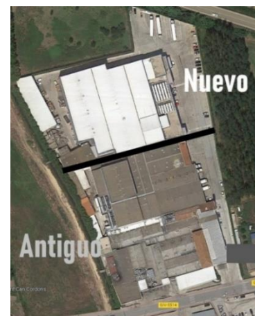
Figura 4.4: Nave nueva y antigua (Fuente: Sede Catastro)
