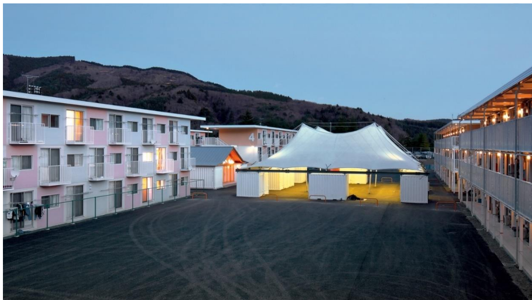
Figura 6. Complex d'habitatges completat (Editorial Arquitectura Viva 2022).
