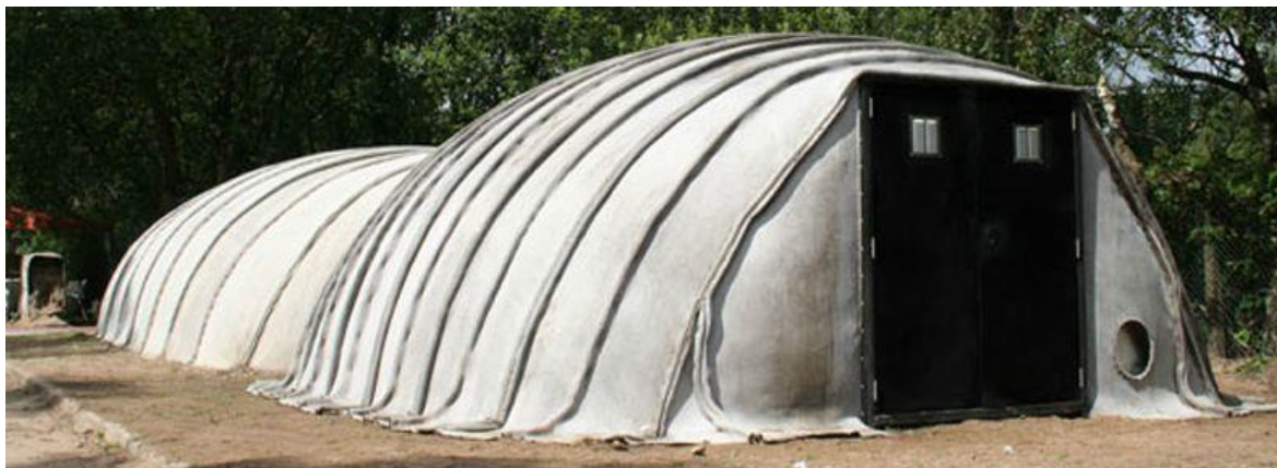
Figura 77. Dos mòduls junts del Concrete Canvas Shelter (Yirka Bob 2011).
