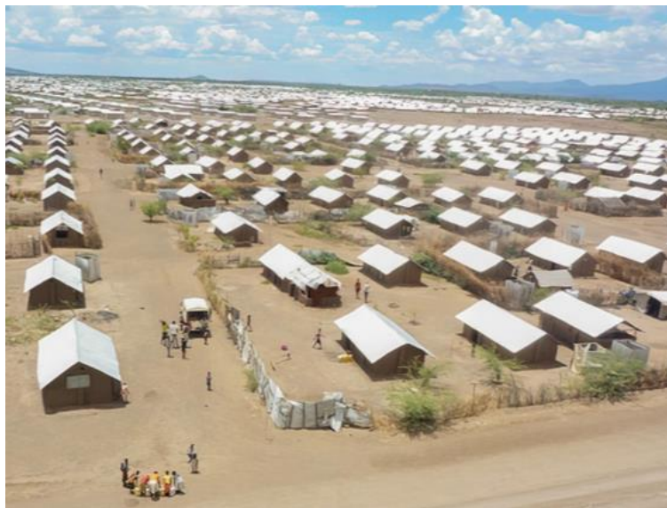
Figura 4. Edificacions al complex del camp de refugiats de Kakuma
