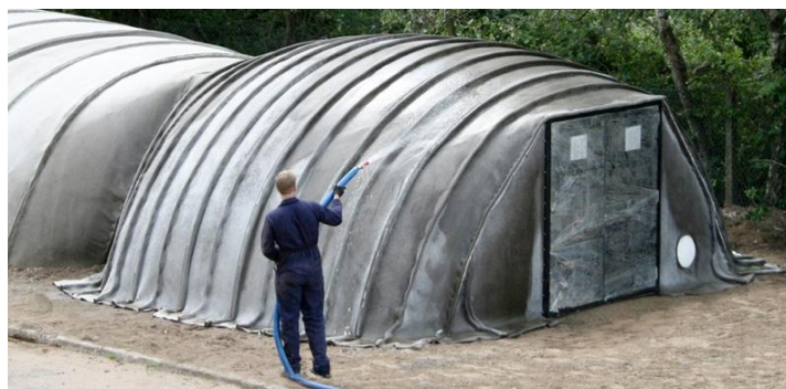
Figura 11. Concrete Canvas Shelter, posada en marxa
