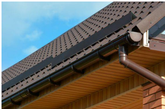
Figura 25. Imatge il·lustrativa d'un canaló i una baixant
