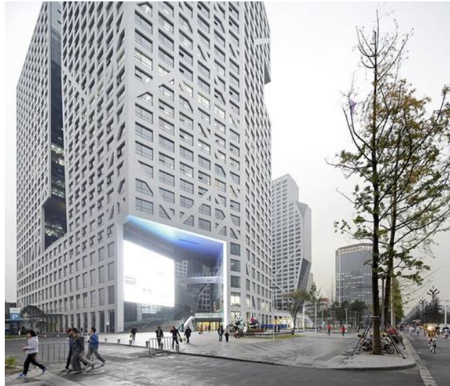
Figura. 6. Galerías de acceso a Sliced Porosity. Steven Holl. 2012.
