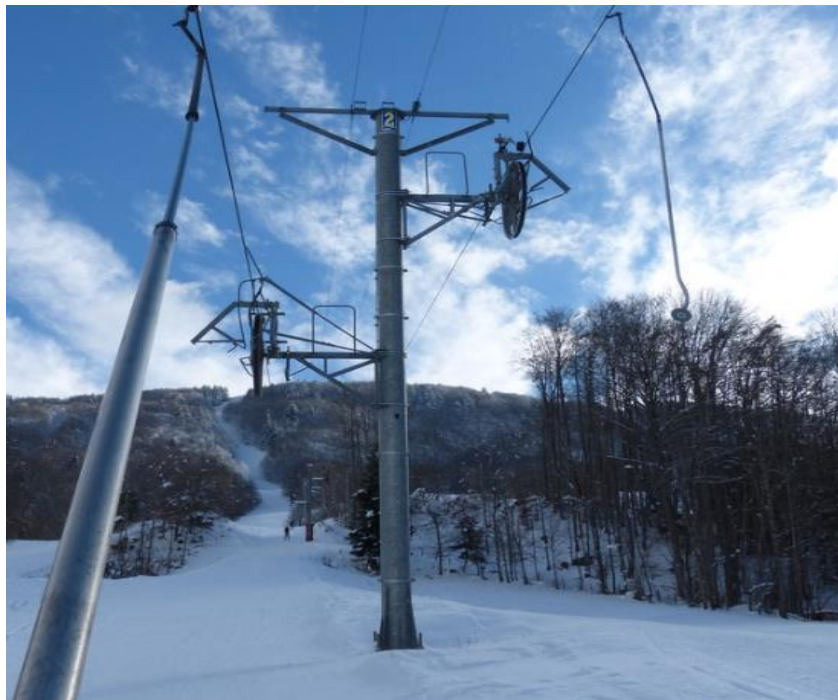
Figura 7 Pilona tubular telesquí, politges de suport, la pilona rep esforços de compressió
