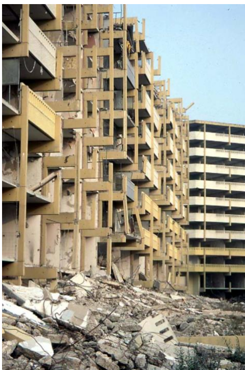
fig. 20 Demolició d'un dels blocs de Bijlmermeer. Font: (Helleman y Wassenberg 2004)
