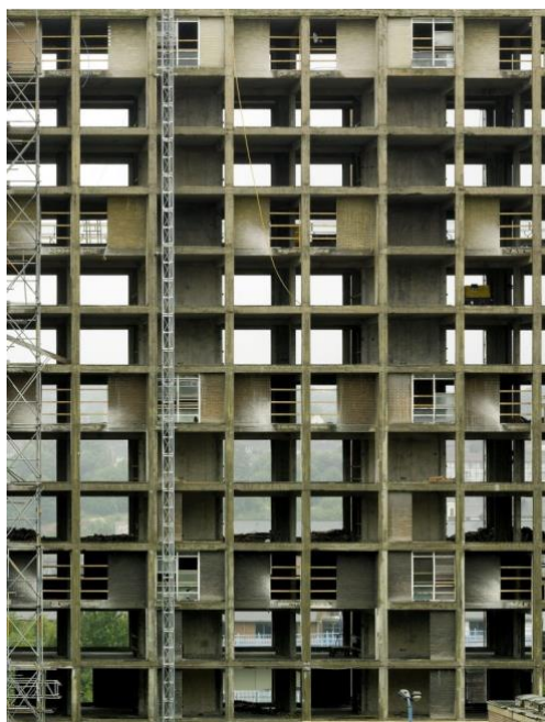
fig. 12 Estructura de formigó despullada durant el procés d'intervenció. Font: The Architectural Review , fotografia de Keith Collie
