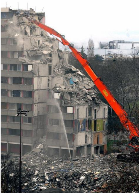
fig. 26 Demolició d'un dels blocs a Bellefontaine, Toulouse Le Mirail. Font: ladepeche.fr
