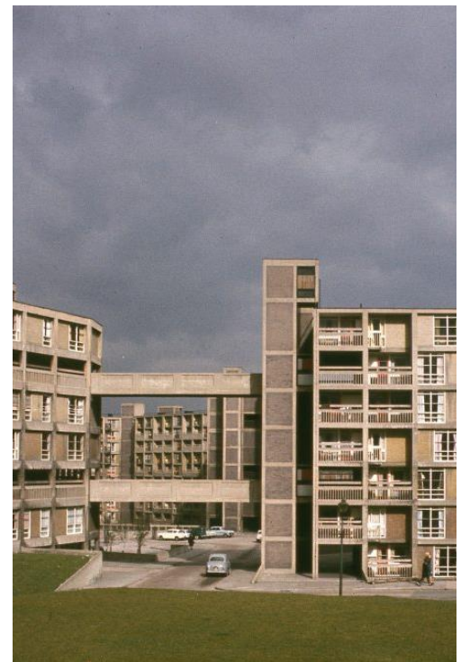
fig. 11 Circulacions contínues entre blocs a través dels "carrers a l'aire". Font: RIBA Library Photographs Collection
