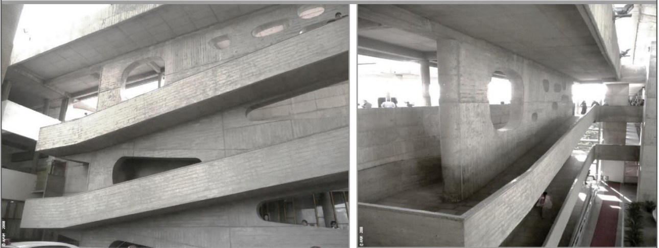
Ilustración 16- "Rampas de acceso al Palacio de Justicia"/Le Corbusier - Chandigarh, 1962
