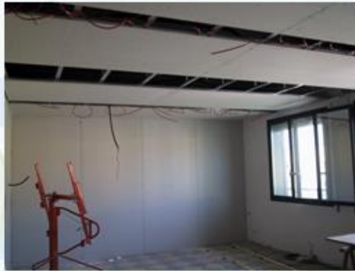
Tuberías incorporadas en paneles
