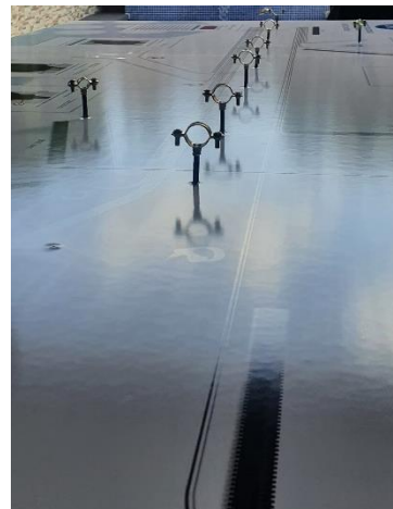
Il·lustració 89 Abraçadores instal·lades (imatge pròpia)
