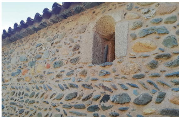
Fig. 6.—Detalle de opus spicatum en muro exterior de Sant Ponç. Fotografía: Óscar Farrerons Vidal.
