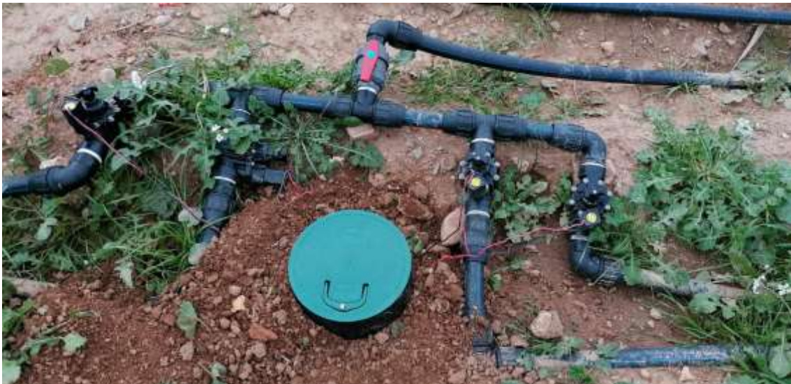
Figura 21 Capçal de reg de l'assaig. Font pròpia.
