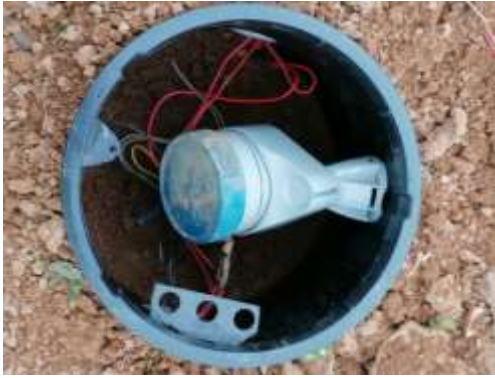
Figura 20 Pericó amb programador i connexions. Font pròpia.
