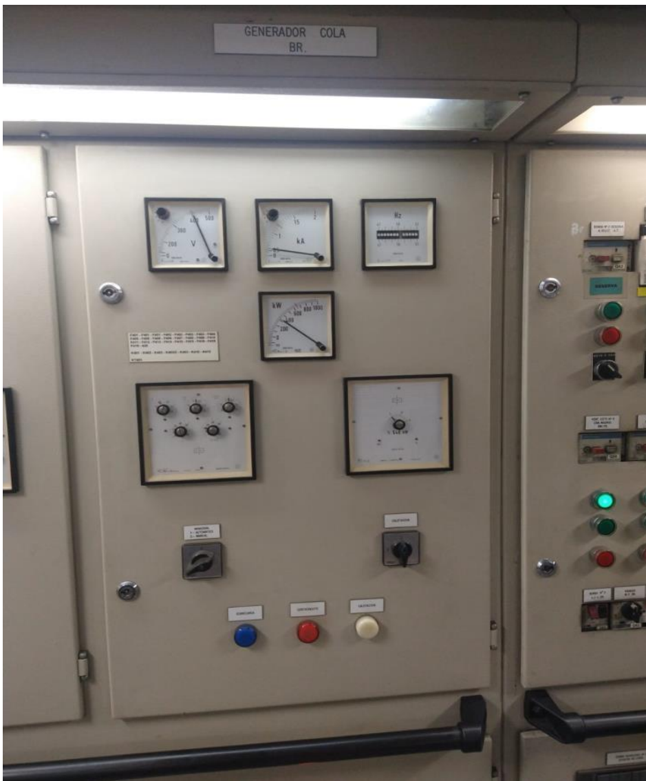
Figura 32: Cuadro del generador de cola – Fuente: Buque real
