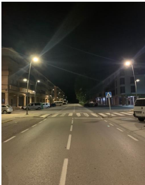
Ilustración 14. Iluminación funcional del área General Miguel Cuervo. Elaboración propia
