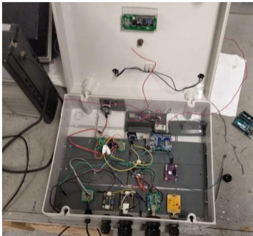
Imatge 67. Primer muntatge dels mòduls i components del sensor. Font: Pròpia.
