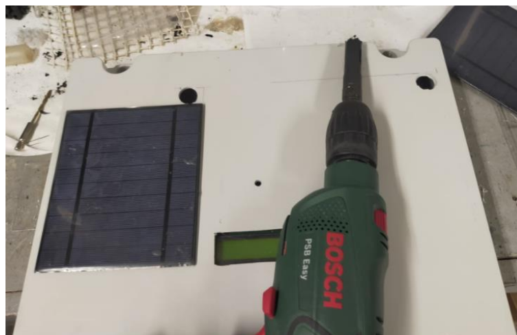
Imatge 65. Realització de les obertures per al cablejat de les plaques solars. Font: Pròpia.
