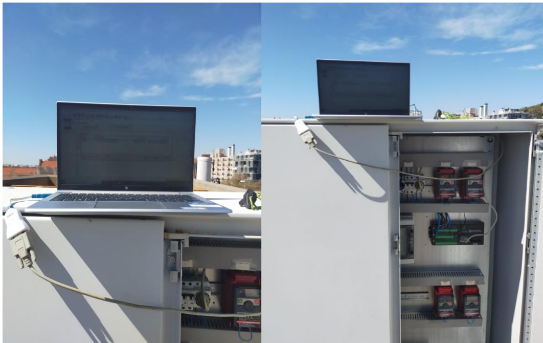
Imatge 41. Recollida de dades del sensor de pH amb el datalogger . Font: Pròpia.
