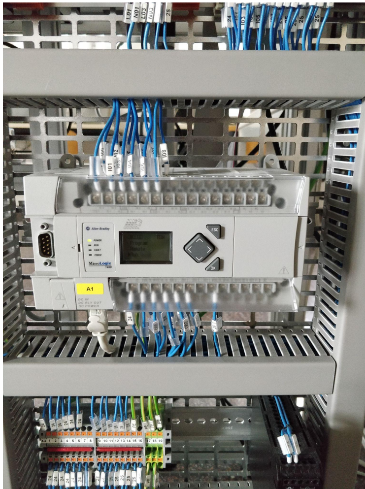
Imatge 3.2 PLC Cèl·lula FAS200 MicroLogix 1400
