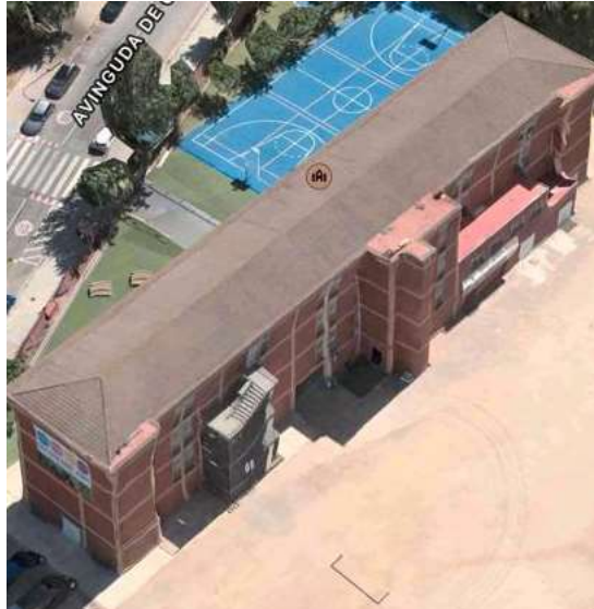
Figura 22. Façanes de la part del darrere de l'edifici (Font: pròpia)
