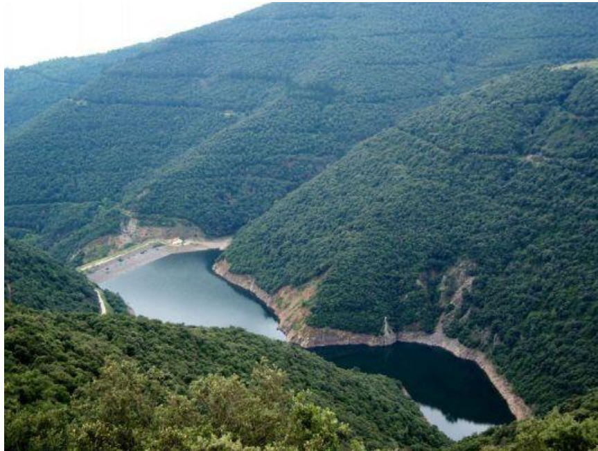
Figura 11. Vista panoràmica de l'embassament de Vallforners. Font: Moianes.net
