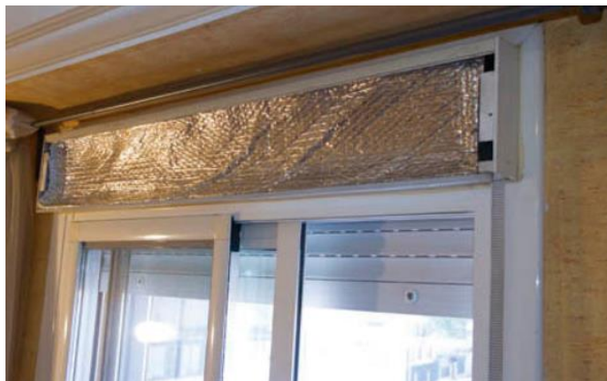
Il·lustració 35. Kit multicapa d'alumini per aïllar caixa de persianes
