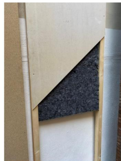
Il·lustració 39. Trasdossat amb bastidor de fusta i mascaretes reciclables com a aïllament
