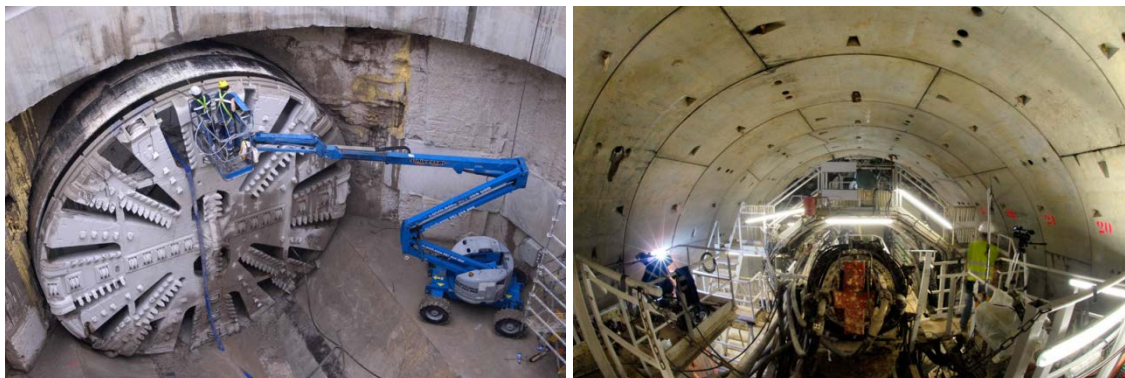
Figura 3.13 Tuneladora empleada en el tramo 1D. a) A la izquierda, vista de la rueda de corte de 9.43 m de diámetro. b) A la derecha, vista del túnel revestido con dovelas, diámetro interior túnel 8.43 m
