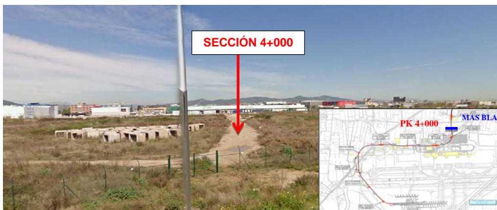
Figura 5.18 Fotografía de la zona donde se ha instalado la sección de control PK 4+000 y planta del trazado del tramo T1D
