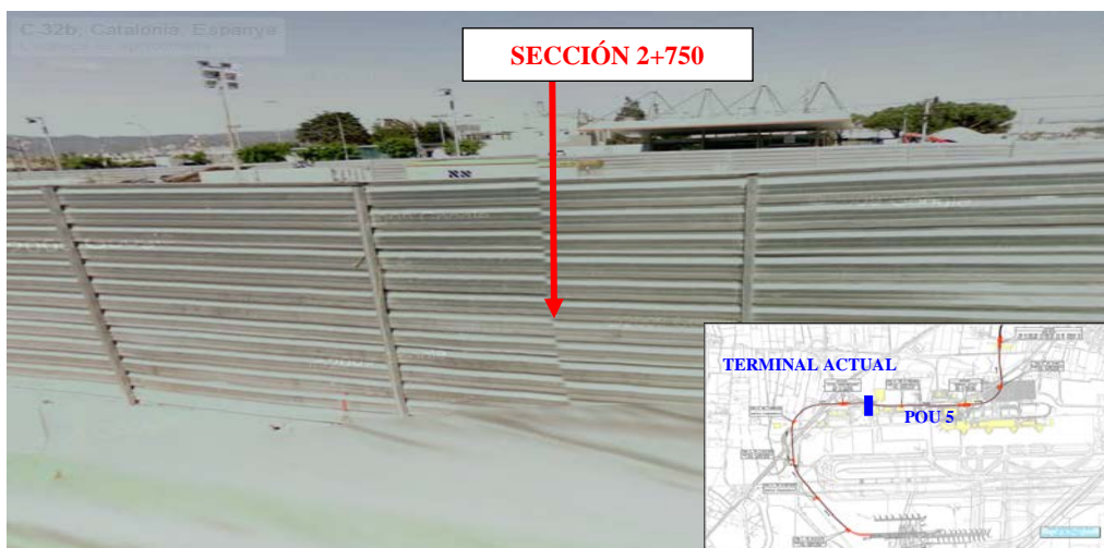
Figura 5.34 Fotografía de la zona donde se ha instalado la sección de control PK 2+750 y planta del trazado del tramo T1D
