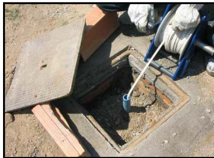
Figura 3.20 Medición de un piezómetro abierto
