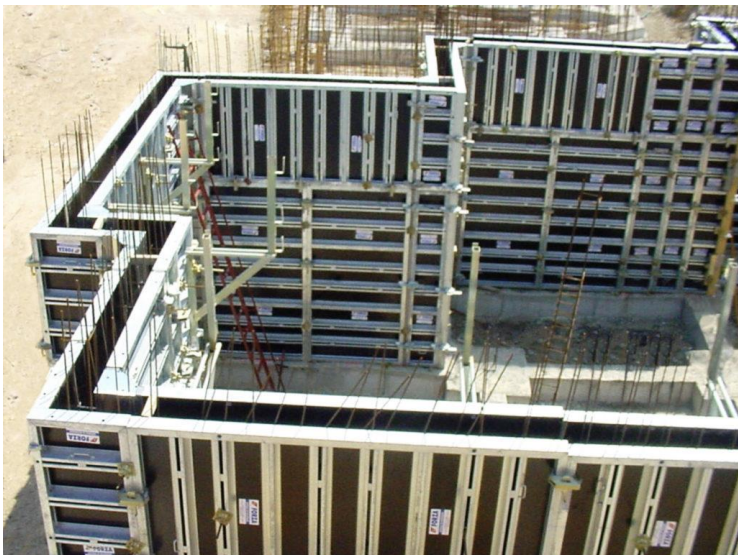
Figura 9 Ejemplo construcción encofrado vertical. Fuente:
