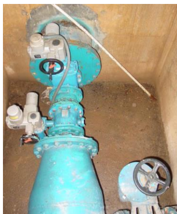
Figura 31. Entrada del dipòsit de la Culla controlat per dues vàlvules (Aigües de Manresa)
