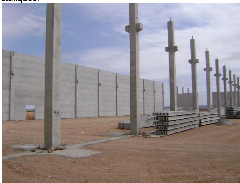
Figura 7: Construcció amb pilars de formigó armat prefabricat. (Font: "Gilva" [20])
