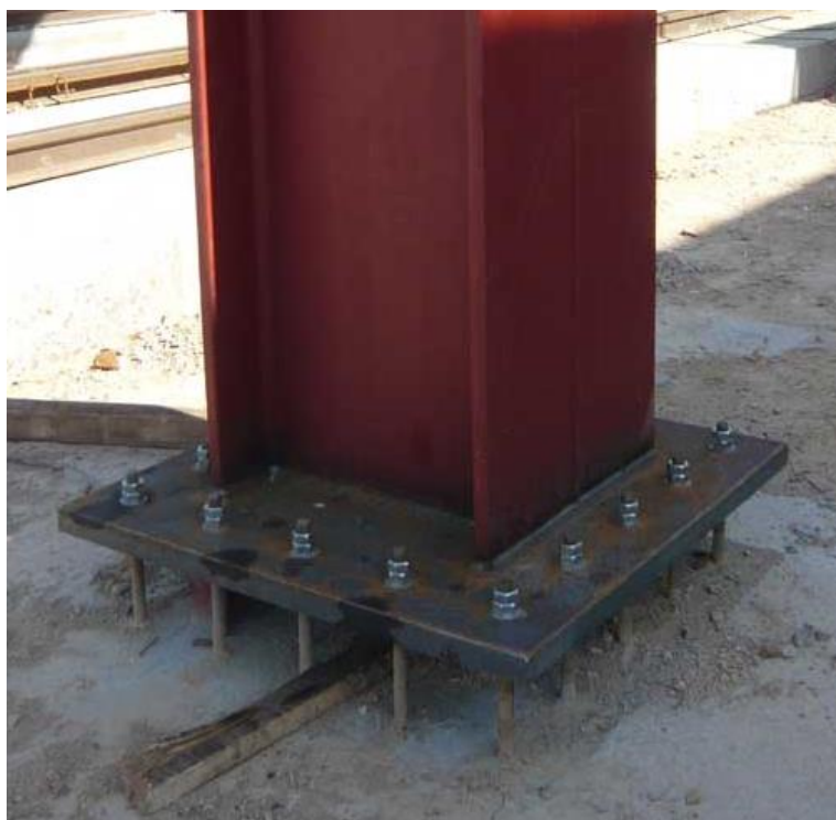
Figura 62: Pletina pel fonament d'una estructura metàl·lica. (Font: "e-struc" [2])
