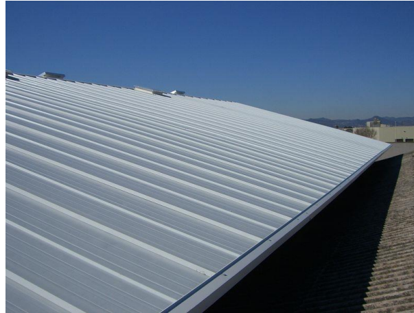
Figura 25: Coberta inclinada metà·lica. (Font: "Sumuvesa" [43])
