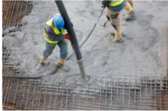
Figura 31: Treballadors abocant el formigó per construir un forjat. (Font: "Grup Curanta" [22])
