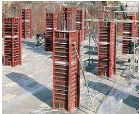
Figura 6: Construcció amb pilars de formigó armat in situ. (Font: "Elisa Capacitació" [12])
