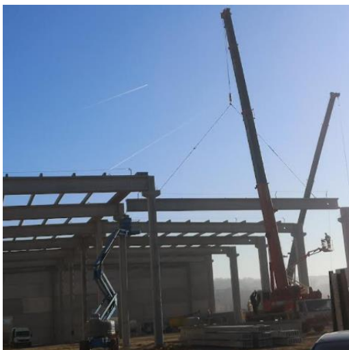
Figura 49: Elevació d'una biga amb maquinària especial. (Font: "Imatge visita nau d'elements prefabricats")
