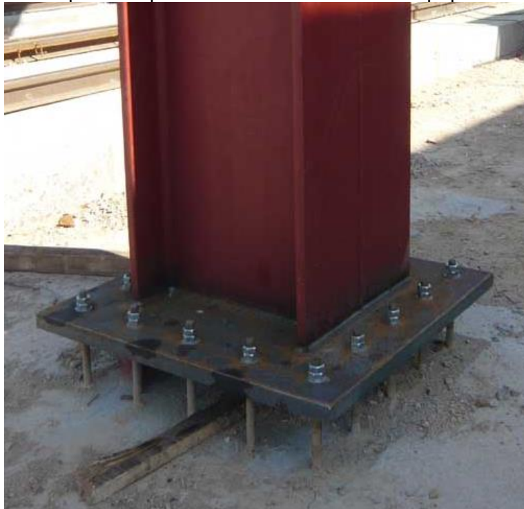
Figura 11: Construcció amb pilars d'estructures metàl·liques. (Font: "e-struc" [2])
