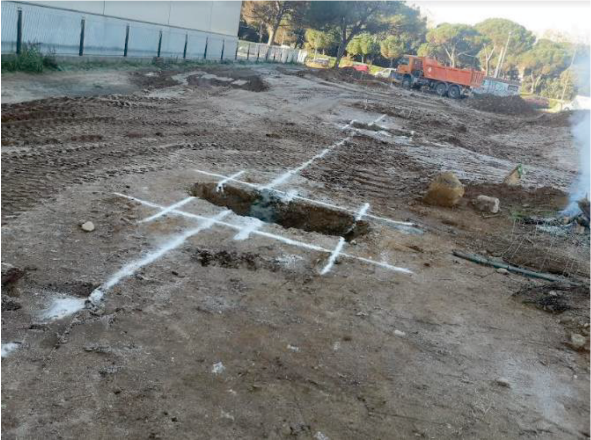
Figura 6: Delimitacions pels fonaments marcats en guix. (Font: "Visita nau d'elements prefabricats")
