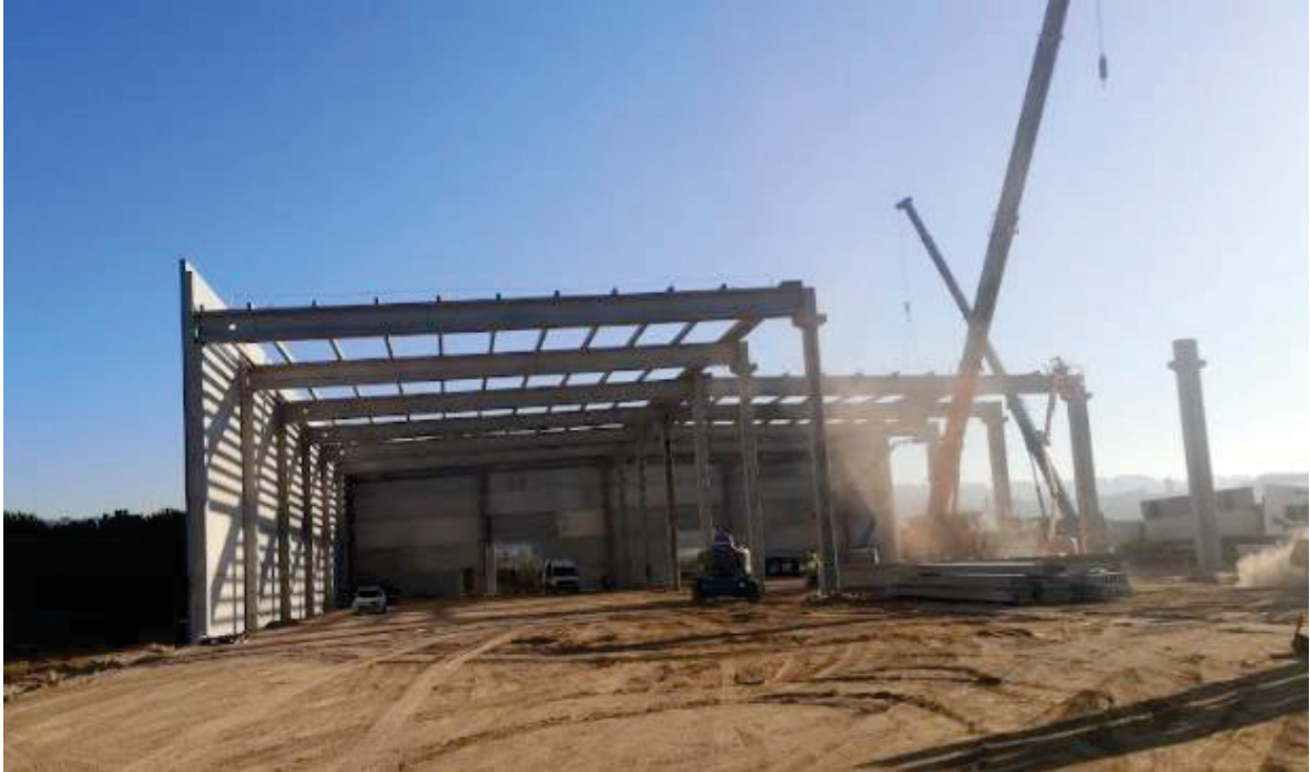
Figura 4: Imatge de la nau en procés de construcció. (Font: “Visita nau d'elements prefabricats”)
