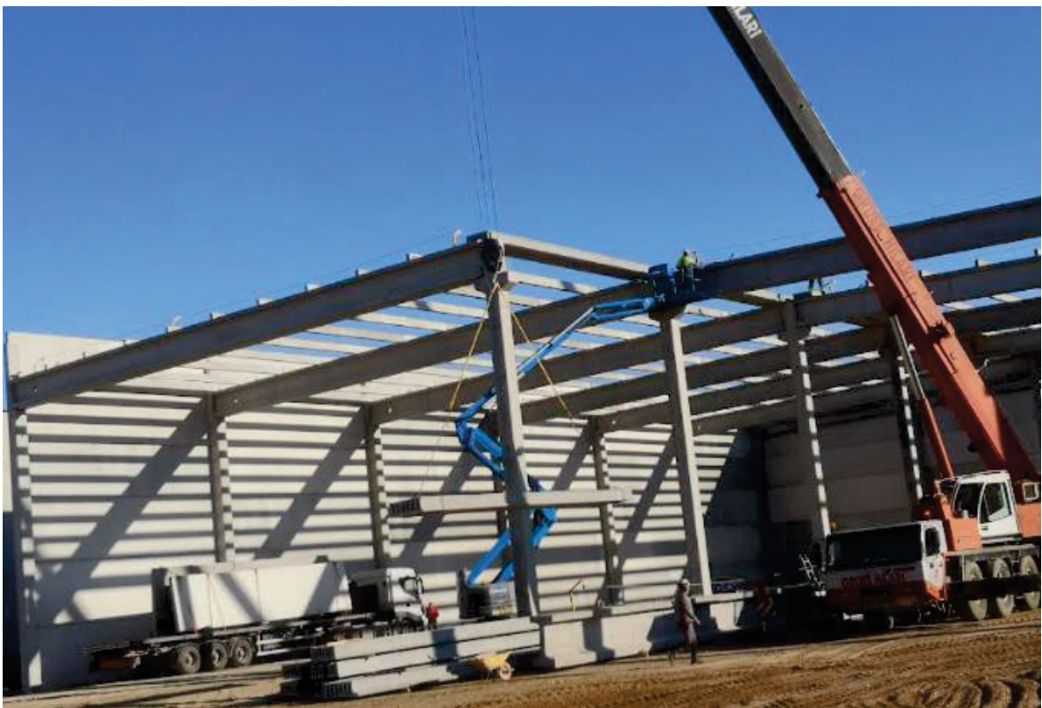
Figura 5: Alçament d'una bigueta tallafoc. (Font: “Visita nau d'elements prefabricats”)
