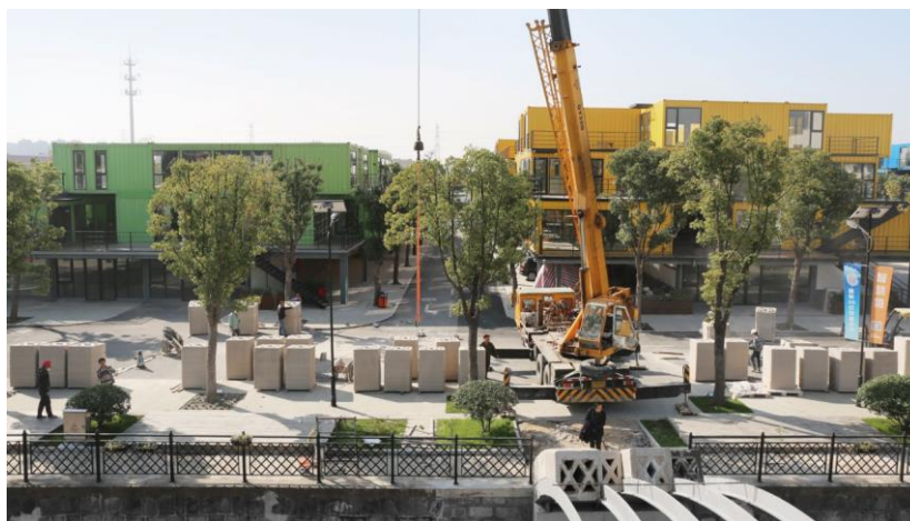
Figura 34. Construyendo el arco, se pueden observar las vigas temporales de acero.
