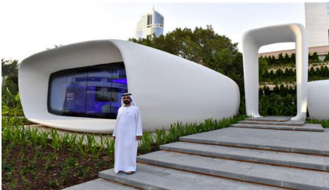
Figura 19: Oficina en Dubai construida por WinSun
