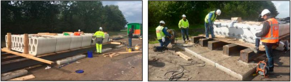
Figura 33 Pretensando el puente en la obra
