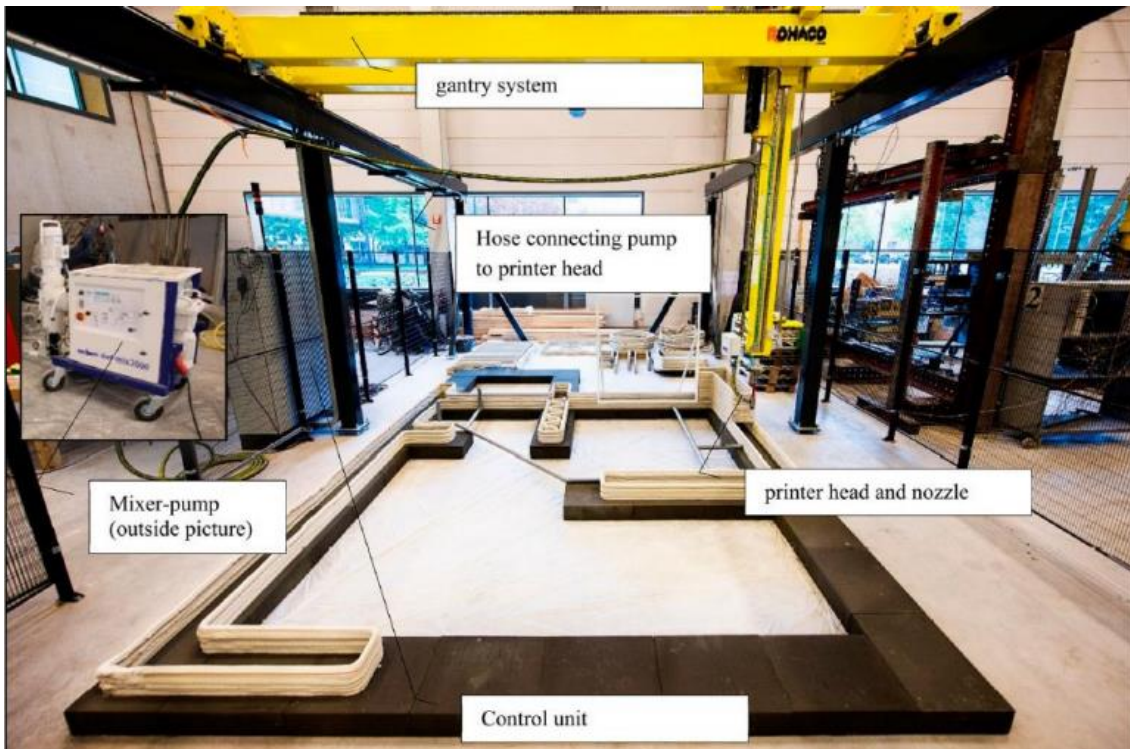
Figure 18: 3DCP Instalación 3DCP en la TU Eindhoven
