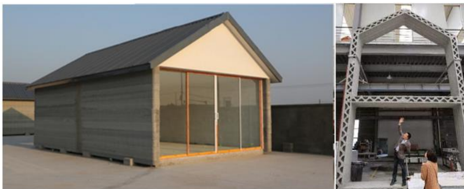
Figura 15 Proyecto de casas prefabricadas y elaboradas por FA en cemento por la empresa china WinSun.
