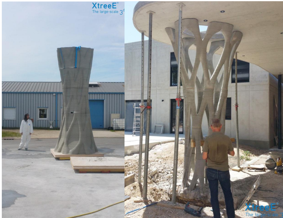
Figura 20: Proyecto de la compañía XtreeE, en la izquierda podemos observar la estructura con soportes provisionales, en la derecha el resultado final.
