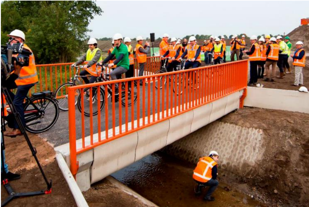
Figura 25. Puente acabado en Países Bajos en 2017
